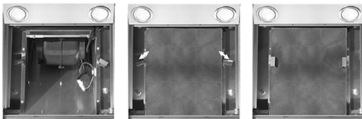
Obr. 9. Výměna uhlíkových filtrů instalovaných těsně před turbínou (kazety)
