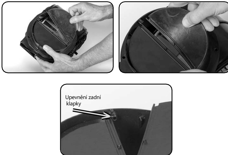
Obr. 4. Instalace zpětných klapek na výstupu z turbíny
